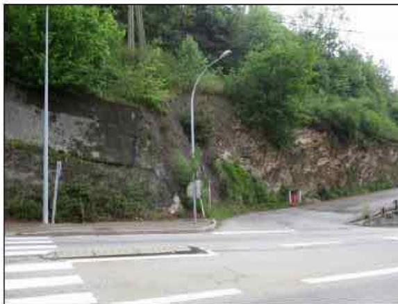
Photo 11: Talus rocheux le long de la RN 85
