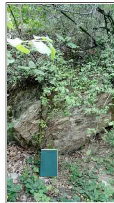
Photo 7: Bloc pouvant potentiellement basculé dans le versant
