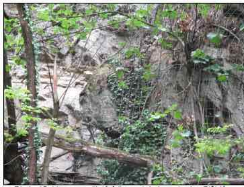
Photo 15: bloc emmaillotté à l'amont de la route des Plâtrières
