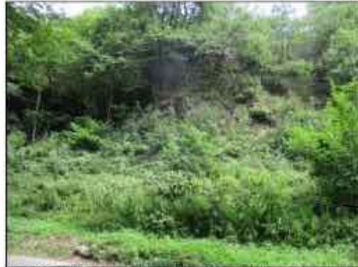
Photo 22: Petite falaise générant des chutes de blocs, sur la route de Jouchy
