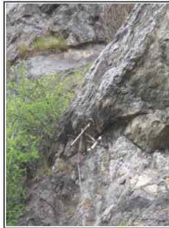
Photo 17: instrumentation du massif rocheux
