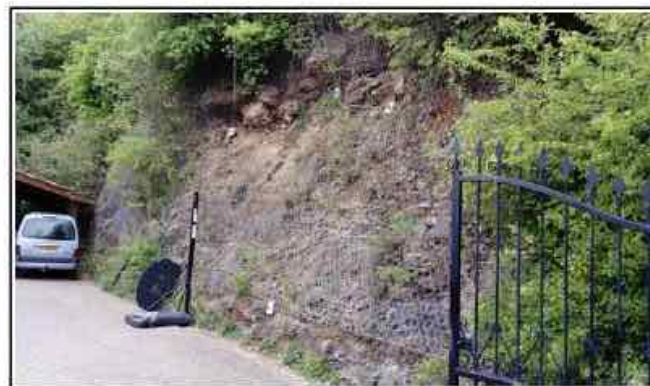
Photo 9: Instabilité d'un talus dans une propriété au lieu-dit « Le Verger »
