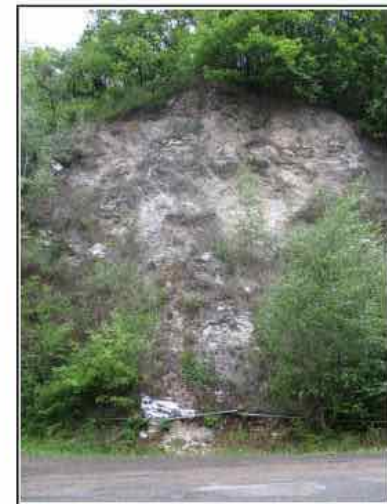
Photo 19: Grillage pendu au niveau de l'école
