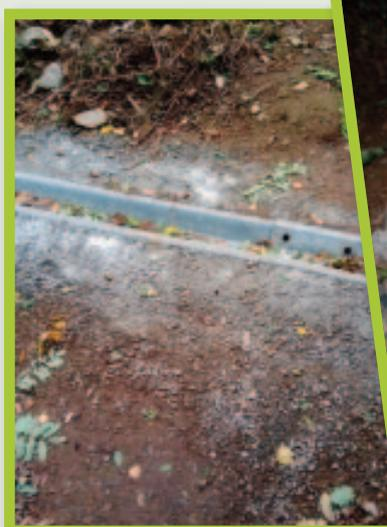
DERRIÈRE LA MAIRIE, INSTALLATION DE GOULOTTES POUR CANALISER LES EAUX PLUVIALES AFIN DE LES EMPÊCHER DE CREUSER LE CHEMIN DANS LES BOIS, QUI DESCEND JUSQU'AU CHEMIN DES PLATRIÈRES
