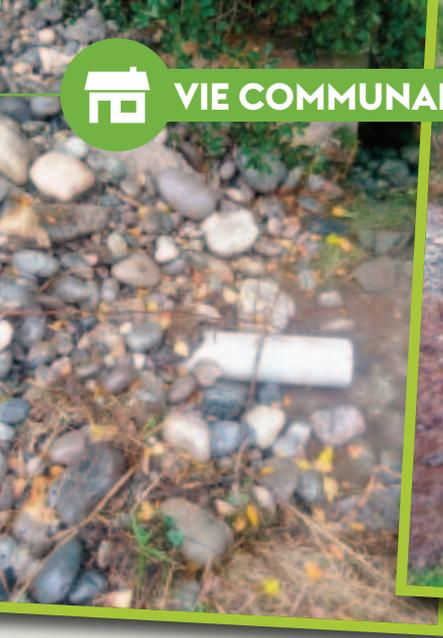
POUR ÉVITER LES INONDATIONS AU CENTRE ÉQUESTRE, CRÉATION D'UN DRAINAGE DE L'EAU ENTRE LE TERRAIN DE FOOT ET LE CENTRE ÉQUESTRE
