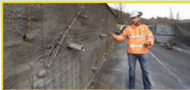
Mur de soutènement de l'école
