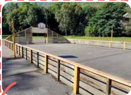
Réfection du city stade - Avant
