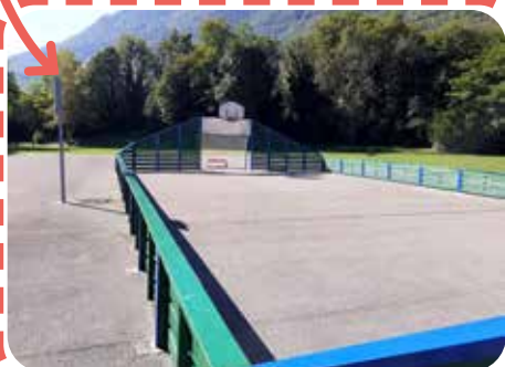
Réfection du city stade - Après
