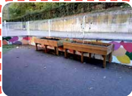
Installation de grandes jardinières pour que les enfants fassent des plantations.
