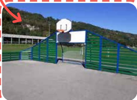
Réfection du city stade - Après
