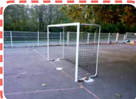
Dépose des paniers de basket et pose de cages de handball.
