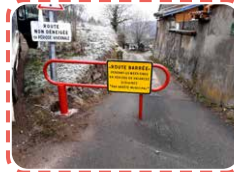
Pose d'une barrière à St Sauveur
