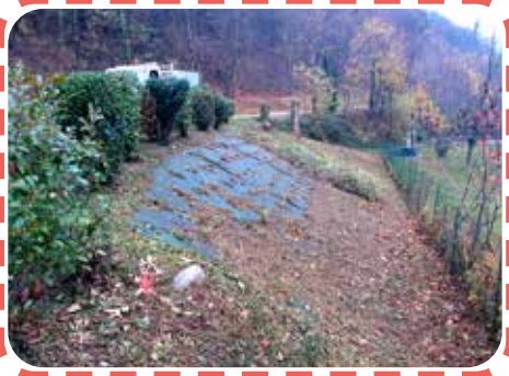
Débroussaillage d'un talus au Moulin
