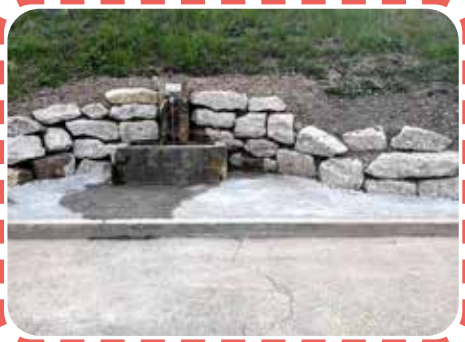
Réfection d'une fontaine aux Terrasses de la Romanche
