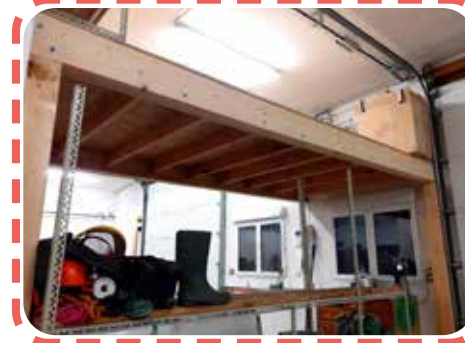
Fabrication d'une mezzanine aux services techniques
