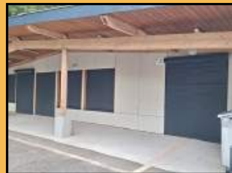
Changement des volets du bâtiment du moulin
