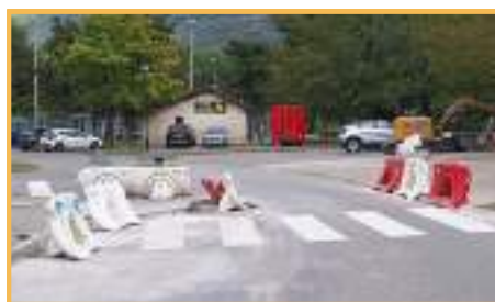
Déplacement du passage piéton et reprise des trottoirs aux abords du stade
