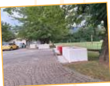
Pose de blocs de béton pour prévenir l'intrusion des gens du voyage sur le stade de foot
