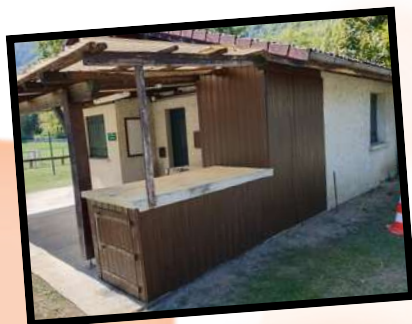
Remise en état des boiseries et des volets du club de tennis
